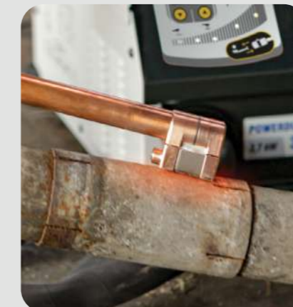
Deblokkeren van een uitlaat : - Inductoren Small S90 - Powerduction 37LG
