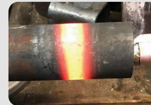
Onderhoud van gasboilers : - Inductor Heat Tube S180/D50 - Powerduction 160LG
